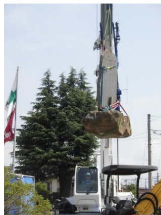
クレーンで吊り上げられ
